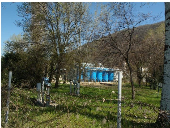
**Foto: Pozzi della barriera idraulica 2 di Miteni (in primo piano) e 6 serbatoi della "fase 4" dei filtri a carbone attivo, installati dopo il 2015. (Foto dell'autore, 2019)**
